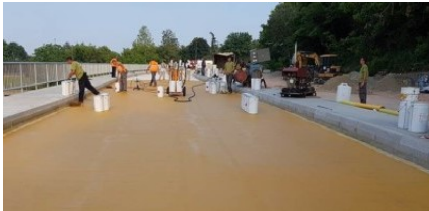
Сл. 87. Поставување на изолација на мост
