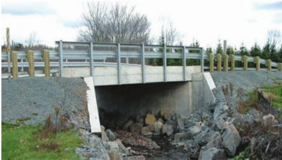
Сл.71. Плочест мост
