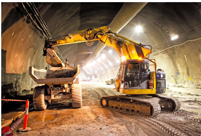
Сл.38. Транспорт на материјал при изведба на тунели
