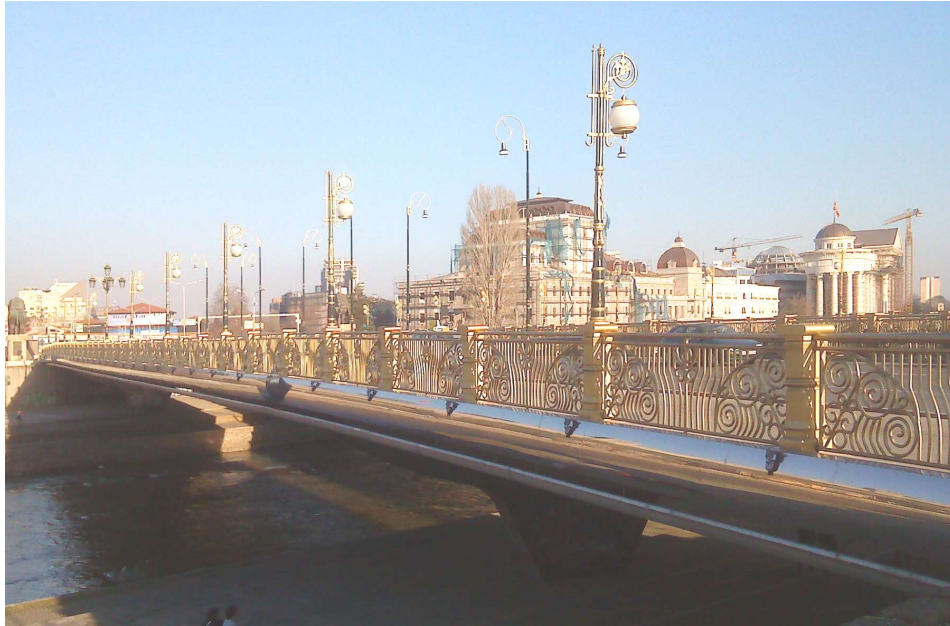
Сл. 86. Осветлување на патен мост
