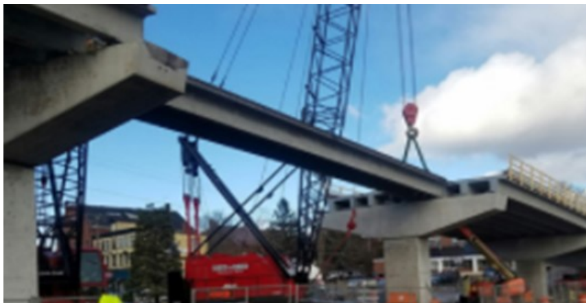
Сл.77. Поставување на префабрикувани монтажни елементи
