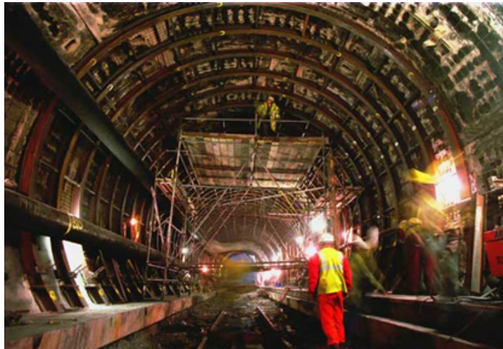
Сл. 24. Поставување на тунелска оплата
