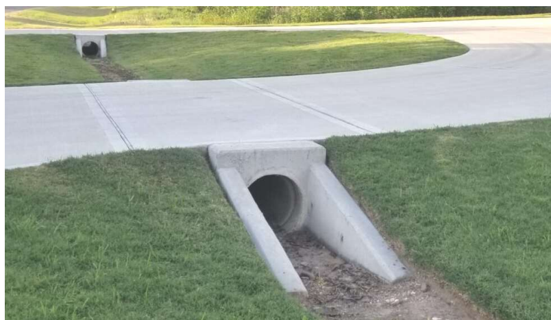
Сл.50. Пропуст со кружен попречен пресек
