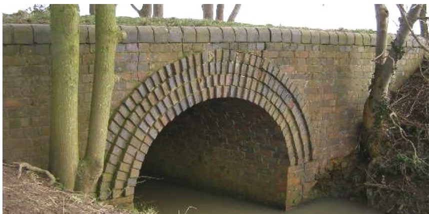
Сл.54 Сводест пропуст
