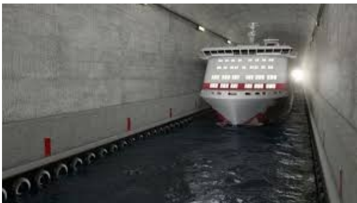
Сл.11. Каналски тунел
