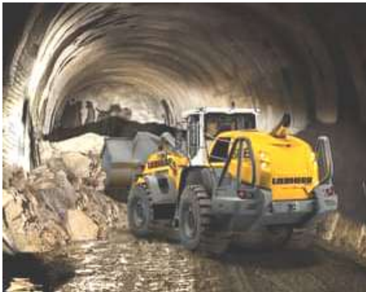
Сл.37. Товарање на материјал при изведба на тунели
