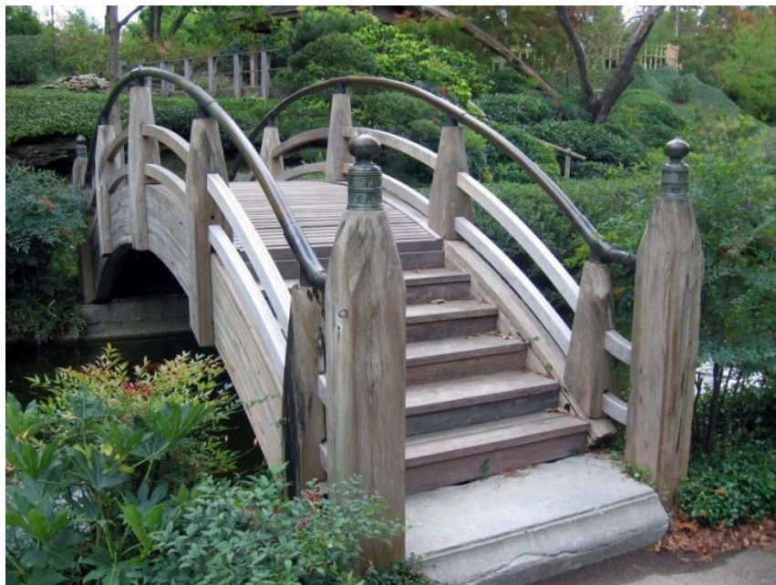
Сл.66. Дрвен мост
