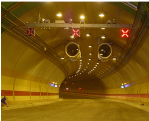
Сл.13. Проветрување на тунел
