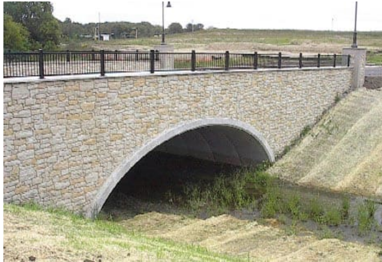
Сл.48. Сводест пропуст
